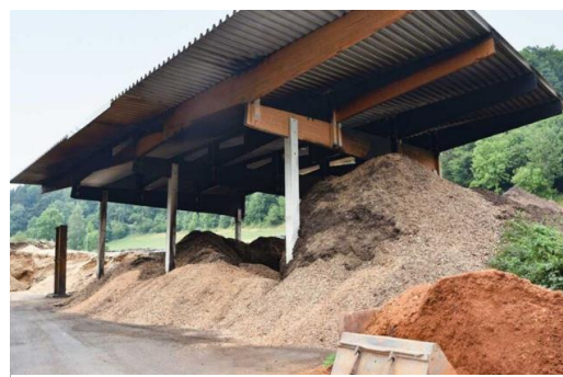
Stock de plaquettes de bois qui a pris feu. En raison de la hauteur de stockage élevée (environ 7 à 10 mètres), une auto-inflammation du tas de plaquettes a pu se produire. (Photo : IFS/Schallmoser*)
